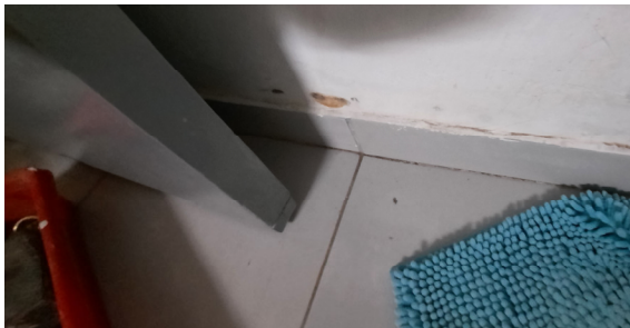
Photographie 1 : Illustrations des contaminations microbiennes identifiées par l'enquêteur (de gauche à droite) : contamination en pied de mur dans salle de bain du Logement GUY-SIMKO-Ames Claires 327 et contamination au plafond de salle de bain du logement MTQ – SMHLM- Walima – Patiraj - 3
