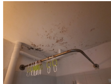
Photographie 1 : Illustrations des contaminations microbiennes identifiées par l'enquêteur (de gauche à droite) : contamination en pied de mur dans salle de bain du Logement GUY-SIMKO-Ames Claires 327 et contamination au plafond de salle de bain du logement MTQ – SMHLM- Walima – Patiraj - 3
