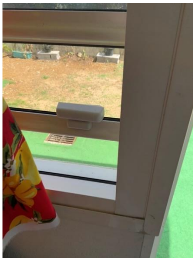
Figure 42 – Illustration de l'instrumentation d'un ouvrant parmi les logements instrumentés
