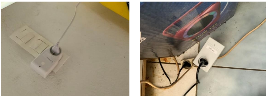
Figure 34 – Illustrations de l'instrumentation de prise de courant parmi les logements instrumentés
